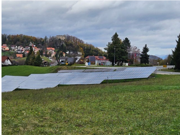
Fotonapetostna naprava na Planini pri Sevnici (občina Šentjur).
